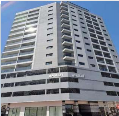
AMALFIBLDG- G+3P+12TYP BLDG., JADDAF, DUBAI
