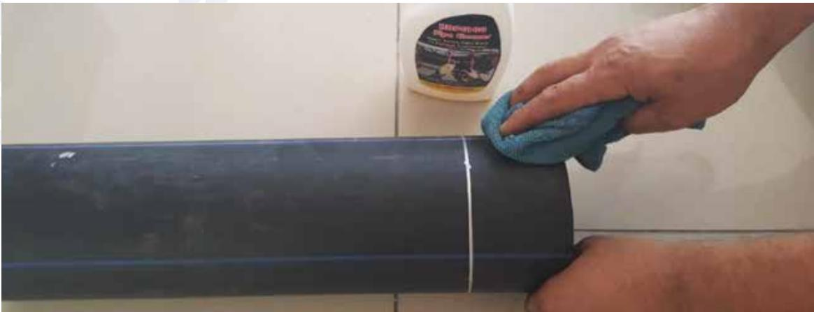
**Temizleme:** Boru uçları temiz ve toz, topraktan arındırılmış olmalıdır. Boru uçlarından çapak ve ya kazma artığı malzemeyi alkollü bez veya alkollü solüsyon kullanarak temizleyiniz. Bu işlemden sonra boru uclarının tekrar kirlenmemesine dikkat ediniz. Manson iç kısmının da temiz olmasına dikkat edilmelidir.
