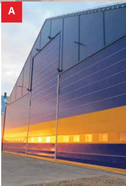
FABRIC TYPE MEGA FOLD-UP HANGAR DOOR
