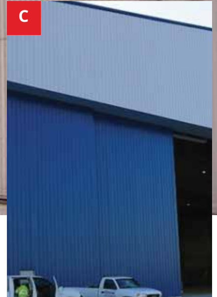
SLIDING TELESCOPIC TYPE HANGAR DOOR
