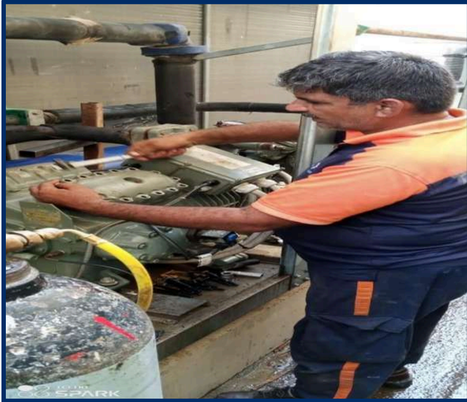
CHILLER COMPRESSORE OVERHUALING
