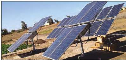
MODEL : 4800 WATT, DISCHARGE : 120'000 LPD (ABUJA , NIGERIA)
