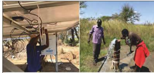
MODEL : 2700 WATT, DISCHARGE : 64'000 LPD (TURKANA , KENYA)
